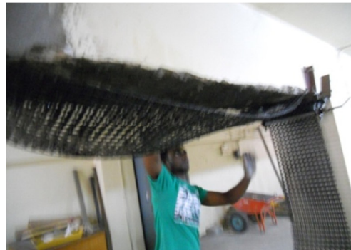
(d) Application of 1st layer of FABmix
